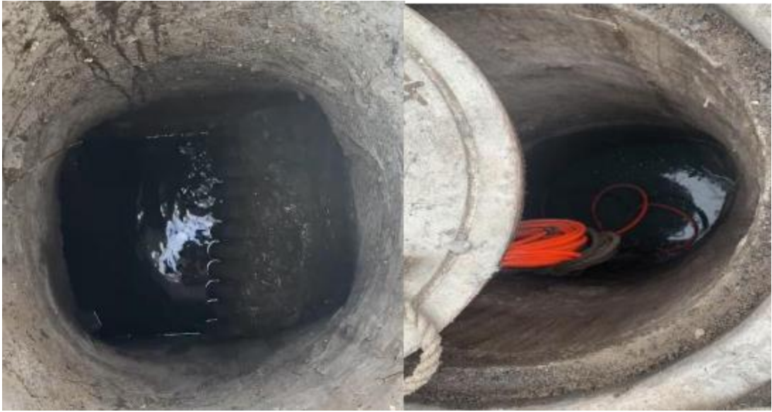
图2-13污水渗漏点及污水主管液位情况
